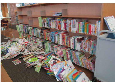
前震後 書架上部のみから落下
