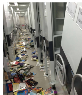
本震直後の免震移動棚 前震で落下した通路上の本が可動棚の動きを妨げ、免震装置が作動せず被害が拡大。
