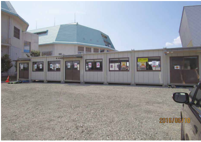
ミナテラスに隣接して設置されたプレハブのコミュニティ施設「よかましきハウス」 この一角に「益城 mini 図書館」が開設された
