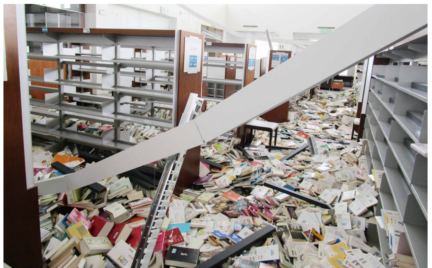
4月14日 前震直後の館内の様子 散乱した14万冊の本と落下した天井の照明により足の踏み場もなかった
