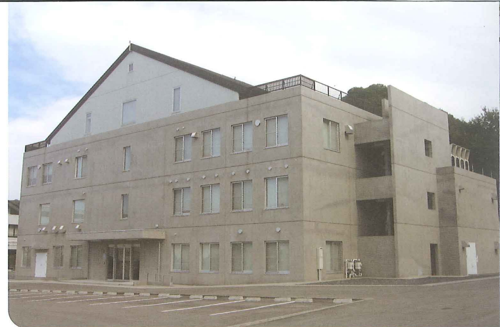
文化財保存修復研究センター外観
