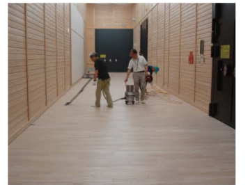
収蔵庫前室兼通路メンテナンス
