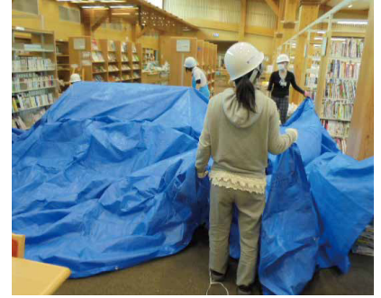
4月21日 破損した壁の粉塵から本を守るためブルーシートで保護
