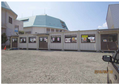
ミナテラスに隣接して設置されたプレハブのコミュニティ施設「よかましきハウス」この一角に「益城mini図書館」が開設された
